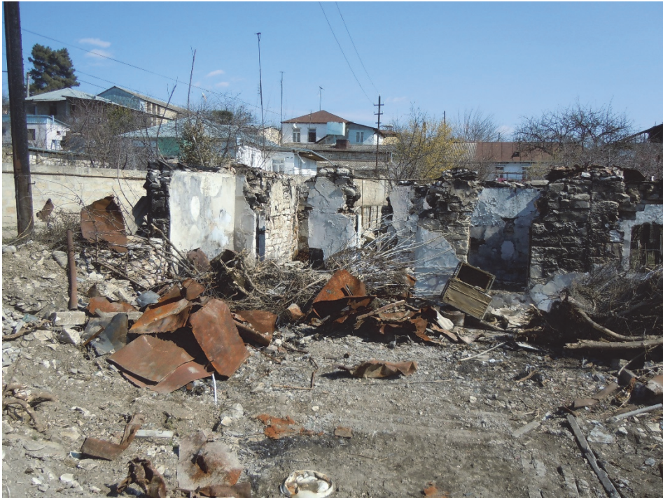
Durch Bomben zerstörtes Haus in Martuni
