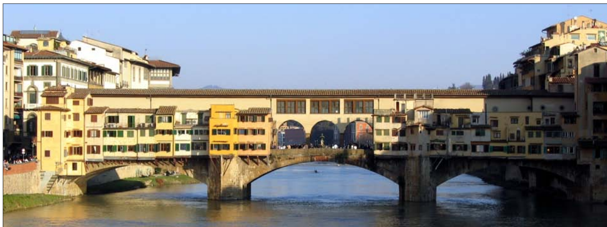
Abbildung 3: Eine Brücke ist manchmal mehr als eine Verbindung zwischen zwei Ufern. 15
